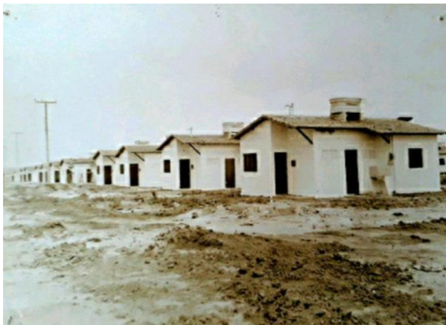
Figura 03 – Padrão construtivo do Conjunto Independência, semelhante ao do Conjunto Santa Delmira
